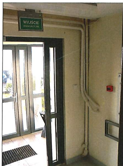
Fot. 7 – Instalacje do obudowy przy drzwiach wejściowych do klatki A
